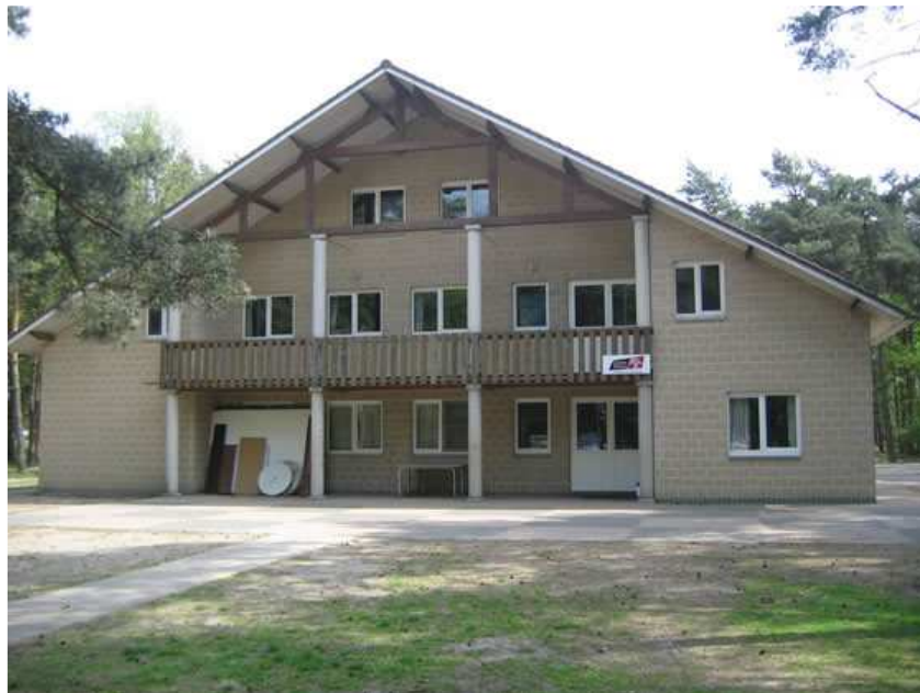
Foto: De Bosuil, het hoofdgebouw op het Jeugd- en Vakantiecentrum.
